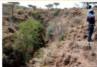
Les petites rigoles deviennent de profonds sillons. Lorsqu'elles se transforment en ravins, des travaux de génie civil sont nécessaires et le problème dépasse les capacités des habitants. (Ethiopie).
